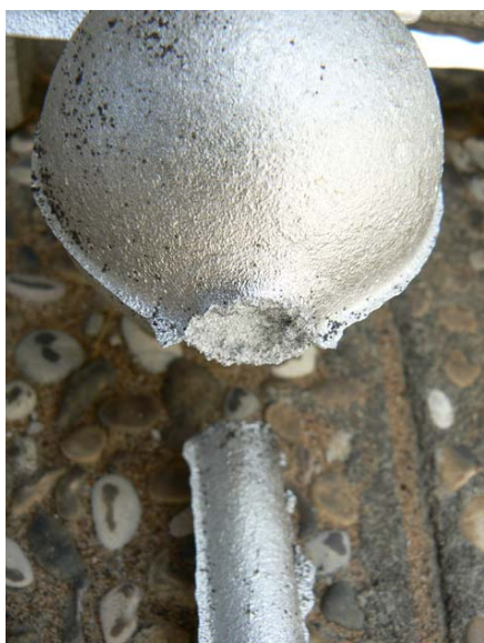
FIGURA 3.5 Esempio di barra rotta
